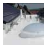
Ein meisterlich ge- dämmtes und abgedichtetes Dach
