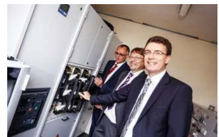
Thorsten Erny, Uwe Nachtigall (E-Werk Mittelbaden) und Eckhard Aßmus (v.r.) nehmen die Anlage offiziell in Betrieb
