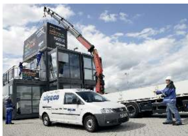
Algeco-Mitarbeiter bei der Montage
