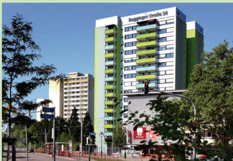
Voraussetzung für den minimalen Energiebedarf ist neben innovativer Haustechnik vor allem eine hervorragende Dämmung der Gebäudehülle. 800 Passivhaus geeignete Fenster von Kneer-Südfenster und deren einwandfreier Einbau leisten dazu einen wesentlichen Beitrag.
