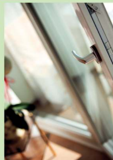
Eingebaut sind Kunststoff-Fenster im Passivhaus-Standard aus der Reihe KF 714 S Exquisit von Kneer-Südfenster. Während für Passivhäuser eine Luftwechselrate von maximal 0,6 pro Stunde zulässig ist, erzielt das Passivhochhaus mit einem Messwert von 0,21 ein Spitzenenergieergebnis.
