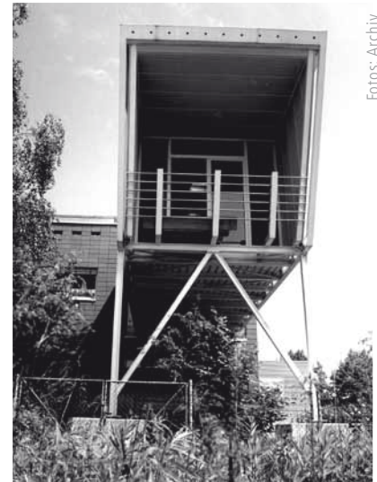
In der auskragenden Stahlkonstruktion blicken die Mitarbeiter bei Besprechungen direkt auf den vorbeifließenden Rhein
