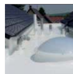
Ein meisterlich ge- dämmtes und abgedichtetes Dach
