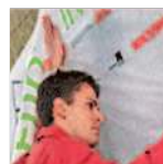
Optimales Dämmstoff entlastet die Umwelt und reduziert den Energieverlust
