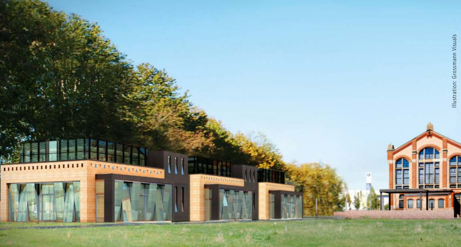
Blick über den Campus am Kesselhaus: Die Pavillons greifen die Farben der historischen Bausubstanz auf
