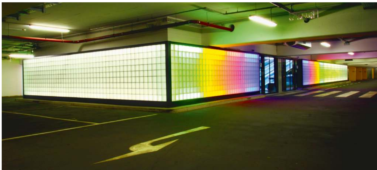
So schön kann ein Parkhaus von innen aussehen: dank Hunderter, hinterleuchteter Glasbausteine
