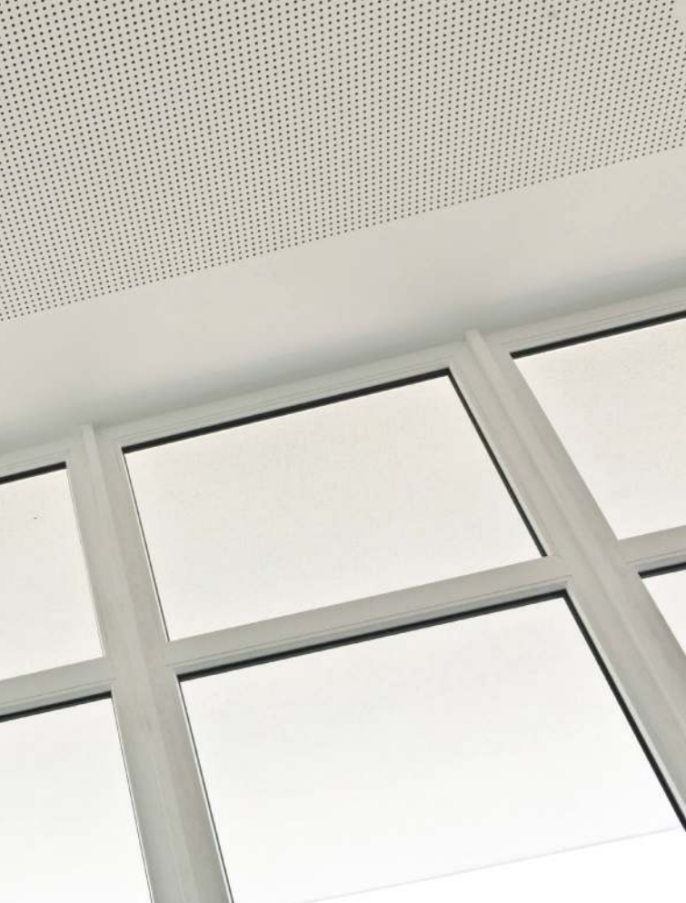
ss war der Innenausbau noch in vollem Gange
