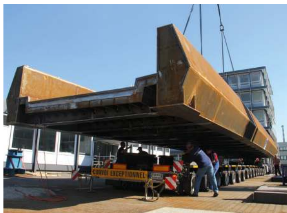
60 Tonnen Stahl wurden für den Schwertransport verladen
