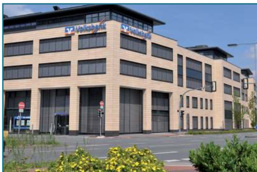
Volksbank, Rheine Wärmepumpengesamtleistung: 600 kW
