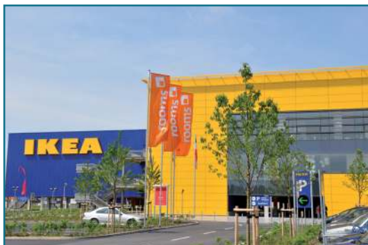
IKEA, Köln Wärmegewinnung aus Grundwasser mit WATERKOTTE Wärmepumpen
