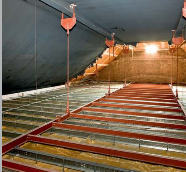
Weitspannträger von Protektor tragen die gesamte Konstruktion aus Brandschutzdecke, Lichtelementen und Akustikdecke
