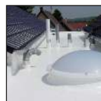
Ein meisterlich ge- dämmtes und abgedichtetes Dach
