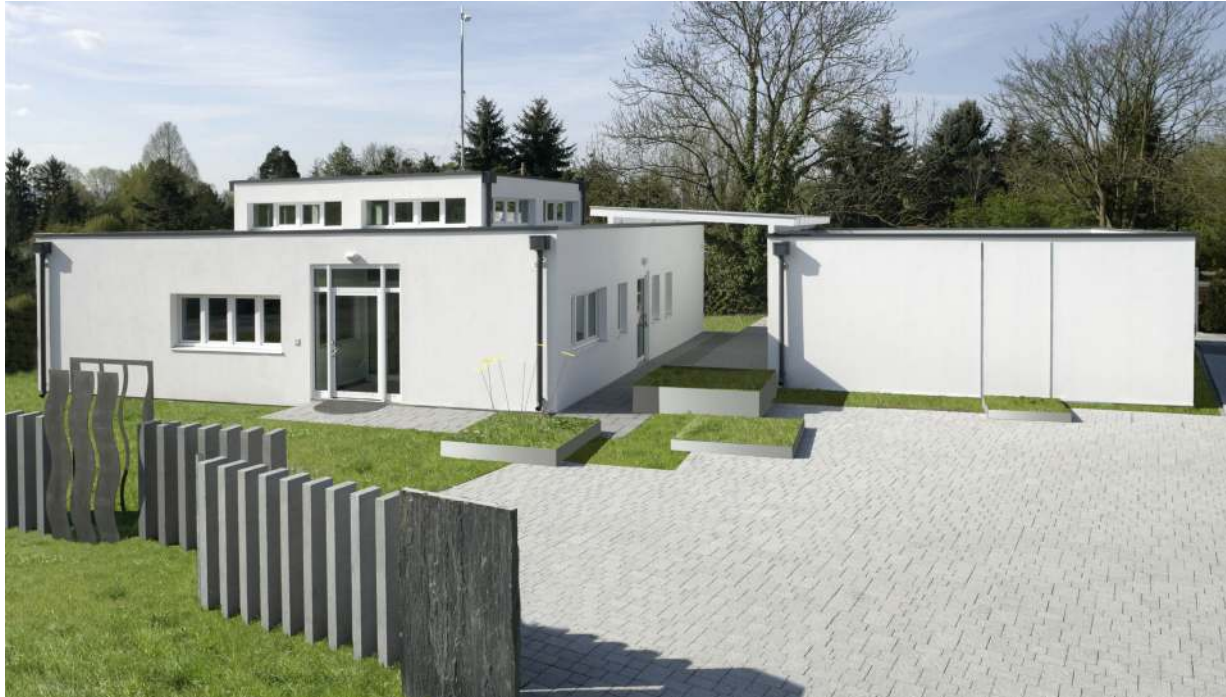
Algeco hat das ansprechende Firmengebäude der Karlsruher Seydell GmbH in nur sechs Wochen Bauzeit erstellt.
