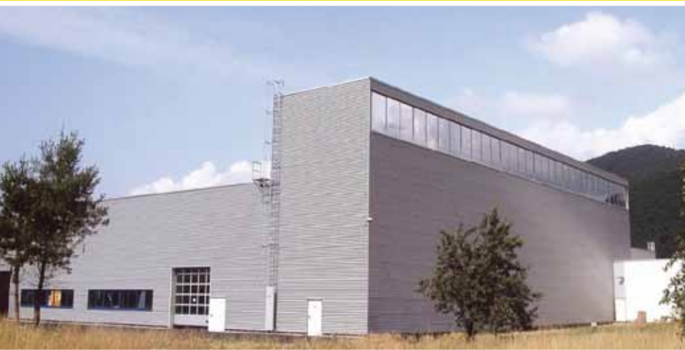
Rietho: Hochregallager in Steinach, Baujahr 2007, 2000 qm Nutzfläche
