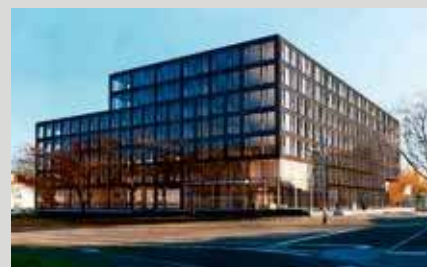
Verwaltungsgebäude: 7000 qm Trockenbauwände, 2000 qm Baffeldecke
