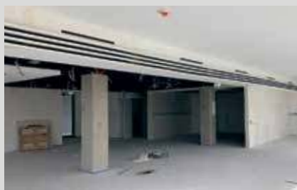
Verwaltungsgebäude: 7000 qm Trockenbauwände, 2000 qm Baffeldecke
