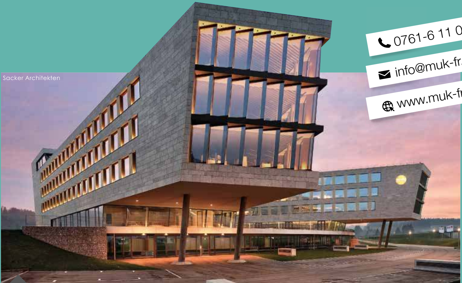
Verwaltungs- und Laborgebäude BA1 + BA2, Celsiusstraße 2, 79822 Titisee-Neustadt
