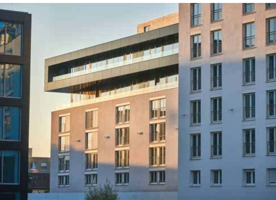
Erste Etappe (oben): Das Hotel Stadt Freiburg wird grundsaniert, bekommt einen imposanten Eingangsbereich mit Restaurant. In der zweiten Bauphase wird der dahinterliegende Riegel (unten) entkernt und aufgestockt
