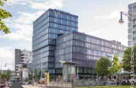
Gewerbekomplex mit Schule und Hotel Bismarckallee 18-20, 79098 Freiburg
