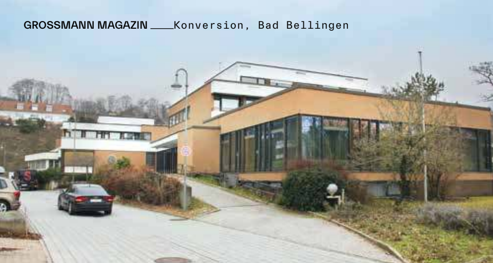
Bad Bellingens Kurklinik-Areal vor dem Einsatz der Grossmann Group: das obere Bild zeigt im Vordergrund das Gebäude, das nach dem Umbau auf den Seiten 30 und 31 in neuem Glanz erstrahlt.
