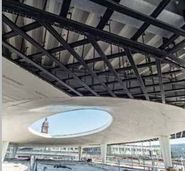
Bei der Decken-Unterkonstruktion wurden C-Deckenprofile mit Längsverbindern, Kreuzschnellverbindern und Noniusabhängern mit Sicherungsklammern verwendet
