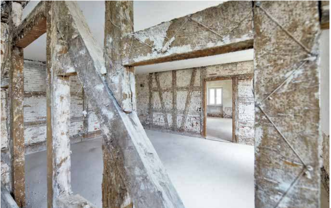
Die historischen Ziegelmauern und Balken sind freigelegt
