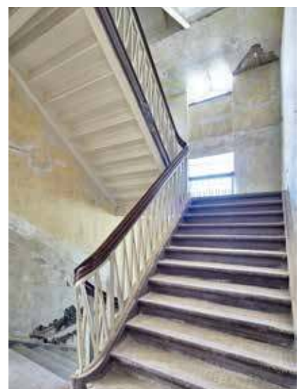
Das großzügige Treppenhaus bleibt erhalten und wird liebevoll saniert
