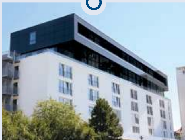
Den Erweiterungsbau des Hotel Stadt Freiburg haben Grossmann Architekten aufgestockt. In Zusammenarbeit mit der Uniklinik Freiburg gibt es hier Krankenzimmer auf Hotelniveau
