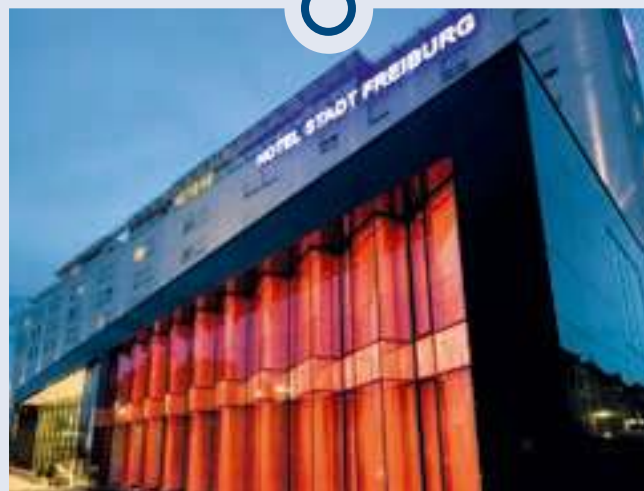
Das Hotel Stadt Freiburg hat Bauherr Roland Burtsche wachgeküsst. Grossmann Architekten haben Lobby und Foyer geplant. Besonders beeindruckend wirkt der eingeschobene Kubus des nachts
