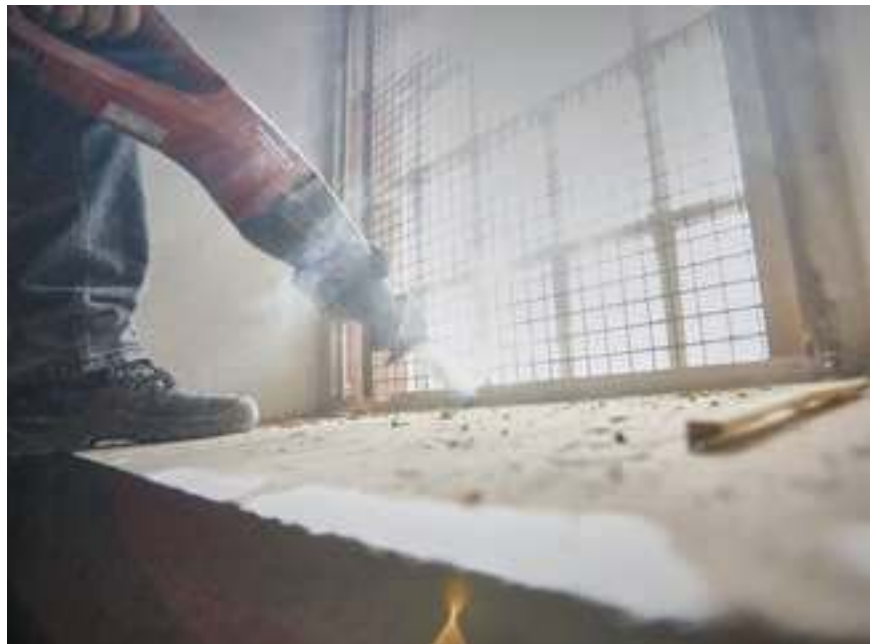
Aufbruch in eine neue Zeit: Draußen bringt die Firma Uhl aus Schuttwald schon Beton für das Fundament – drinnen arbeiten Handwerker an den vergitterten Fenstern der ehemaligen Gefängniszellen
