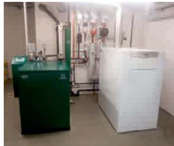
Kleiner Würfel, große Leistung. Das BHKW (grün) neben dem konventionellen Brennerheizkessel für Hochlastzeiten
