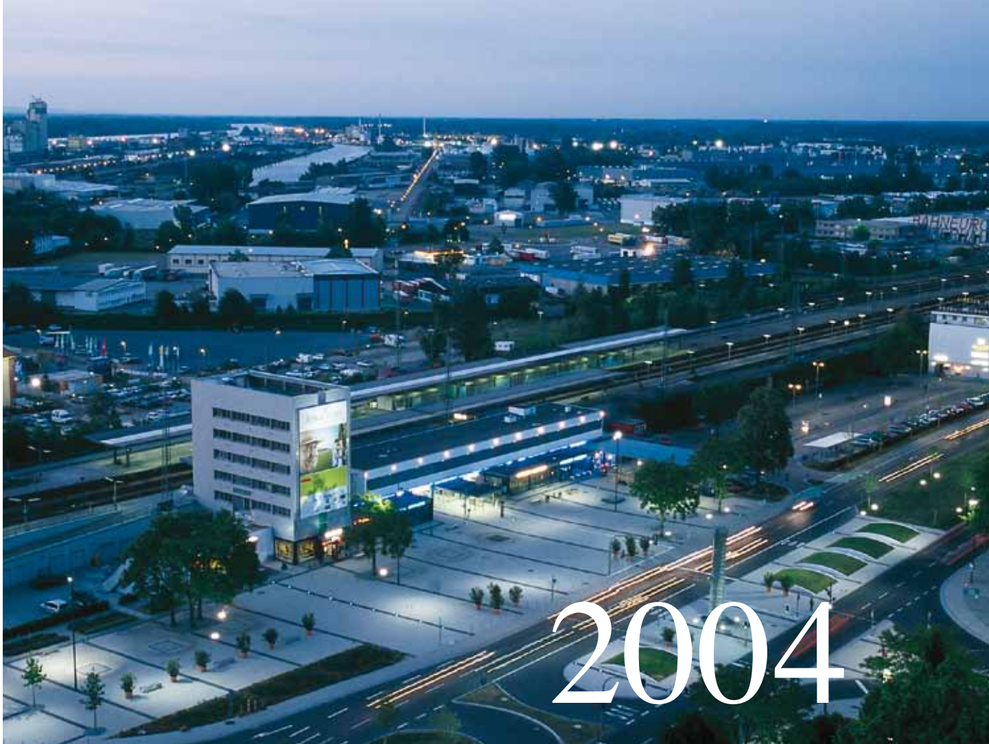
Blick auf den zur Landesgartenschau frisch herausgeputzten Bahnhof Kehl
