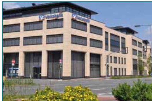
Volksbank, Rheine Wärmepumpengesamtleistung: 600 kW
